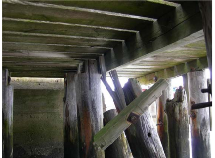
Kuva 91: Tervasaaren huonokuntoinen puulaituri
